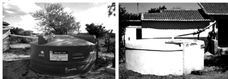
Figura 63 – Exemplos de cisterna em polietileno e em concreto
