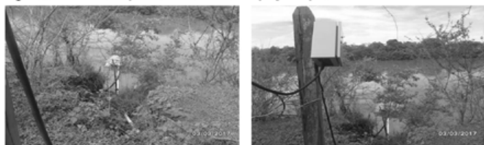
Figura 33 – Flutuante e quadro de comando da captação superficial
