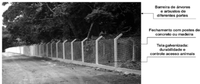
Figura 78 – Isolamentos da área: físico (cercamento) e visual (barreira vegetal)
